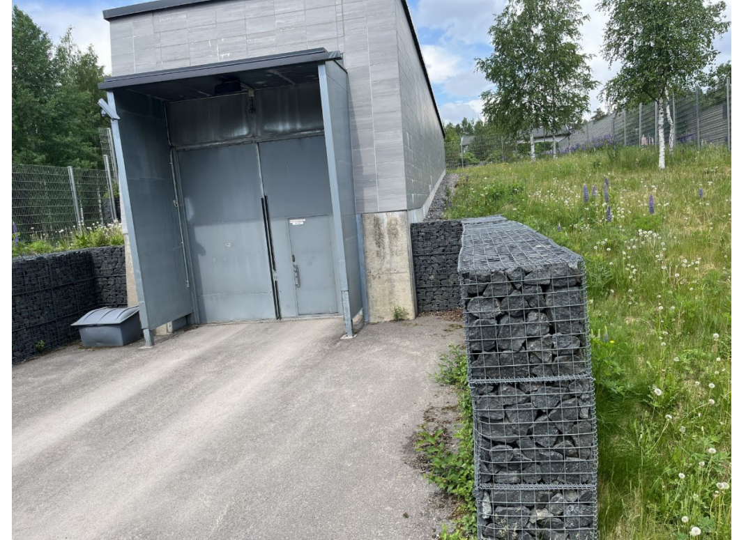
Esimerkki ajotunnelin rakennuksesta
