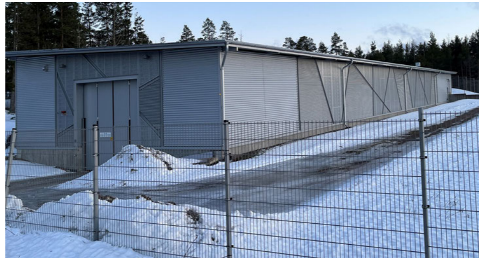
Kuva 2.11 Kehäradan ajotunnelin maanpintarakennus (Kuva: Sitowise Oy)
