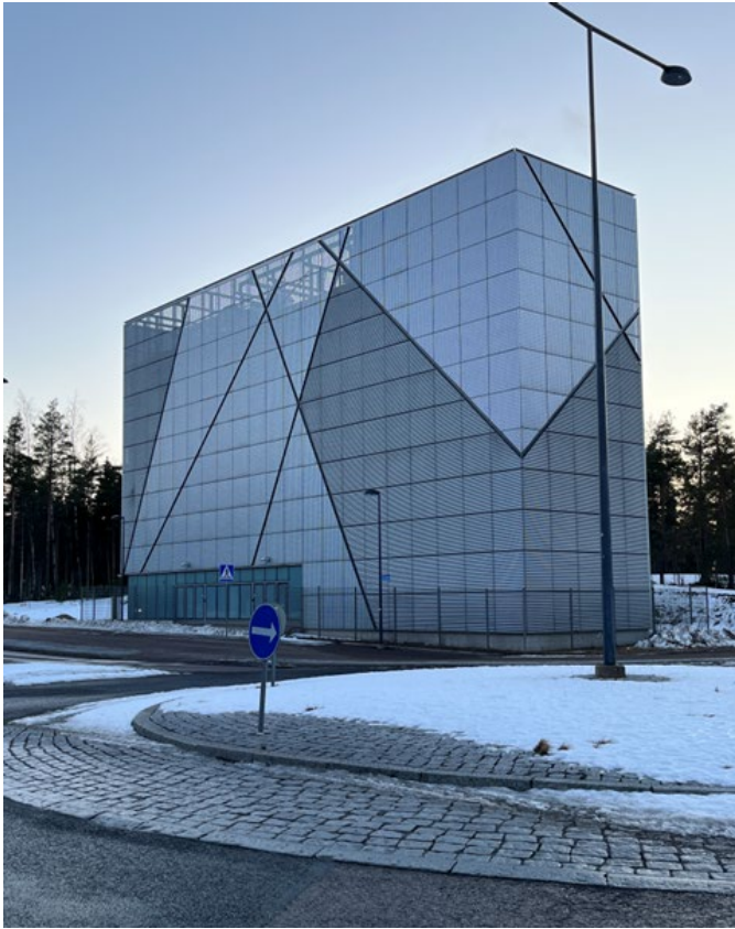
Kuva 5.2 Vantaan Aviapoliksessa sijaitseva Kehäradan tekninen kuilurakennus, jossa ratatunnelia palvelevaa tekniikkaa on sijoitettu maanpäälliseen rakennukseen. Maanpäällisen rakennuksen pituus on noin 33 metriä, leveys noin 8 metriä ja korkeus noin 18 metriä. (Kuva: Sitowise Oy)
