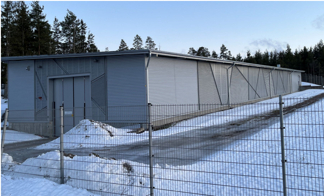
Kuva 5.6 Kehäradan ajotunnelin maanpintarakennus (Kuva: Sitowise Oy)
