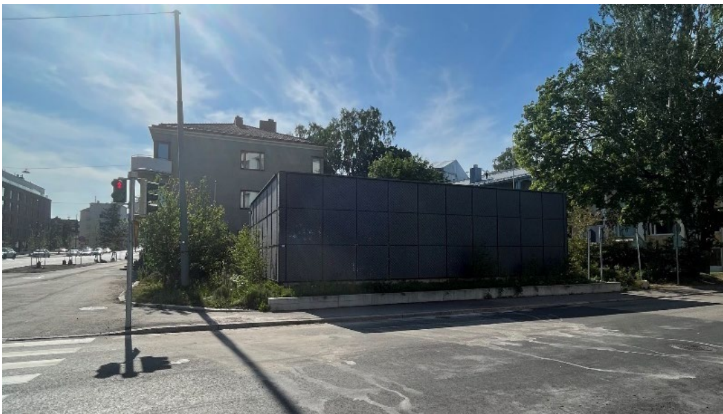
Kuva 5.3 Esimerkki Lauttasaarella sijaitsevasta Länsimetron kuilurakennuksesta, jossa ratatunnelia palvelevaa tekniikkaa on viety mahdollisimman paljon maan alle. Maanpäällisen rakennuksen pituus on noin 16 metriä, leveys noin 12 metriä ja korkeus noin 4 metriä. (Kuva: Sitowise Oy)
